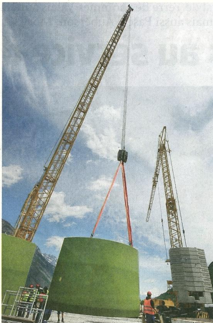
A chantier exceptionnel, grue exceptionnelle. Celle-ci culmine à 120 mètres de hauteur. HOFMANN
