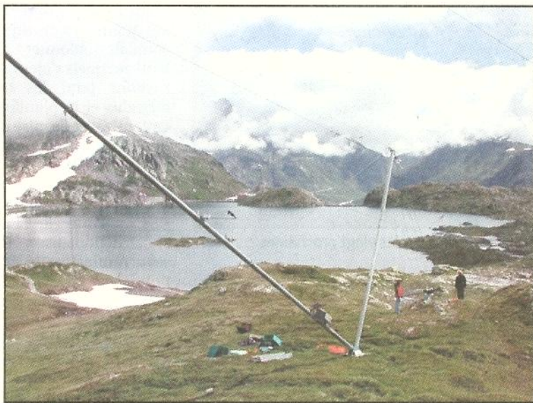
La société Swisswinds a installé son mât de mesure des vents au col du Grimsel. En attendant les vraies éoliennes.
