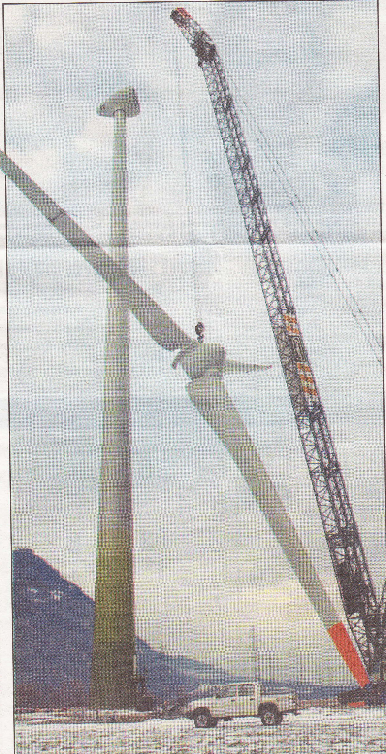
GIGANTESQUE! Il a fallu deux ans d'études et de travaux pour cette éolienne, qui a fini d'être assemblée hier. Chaque pale mesure 33 mètres!
